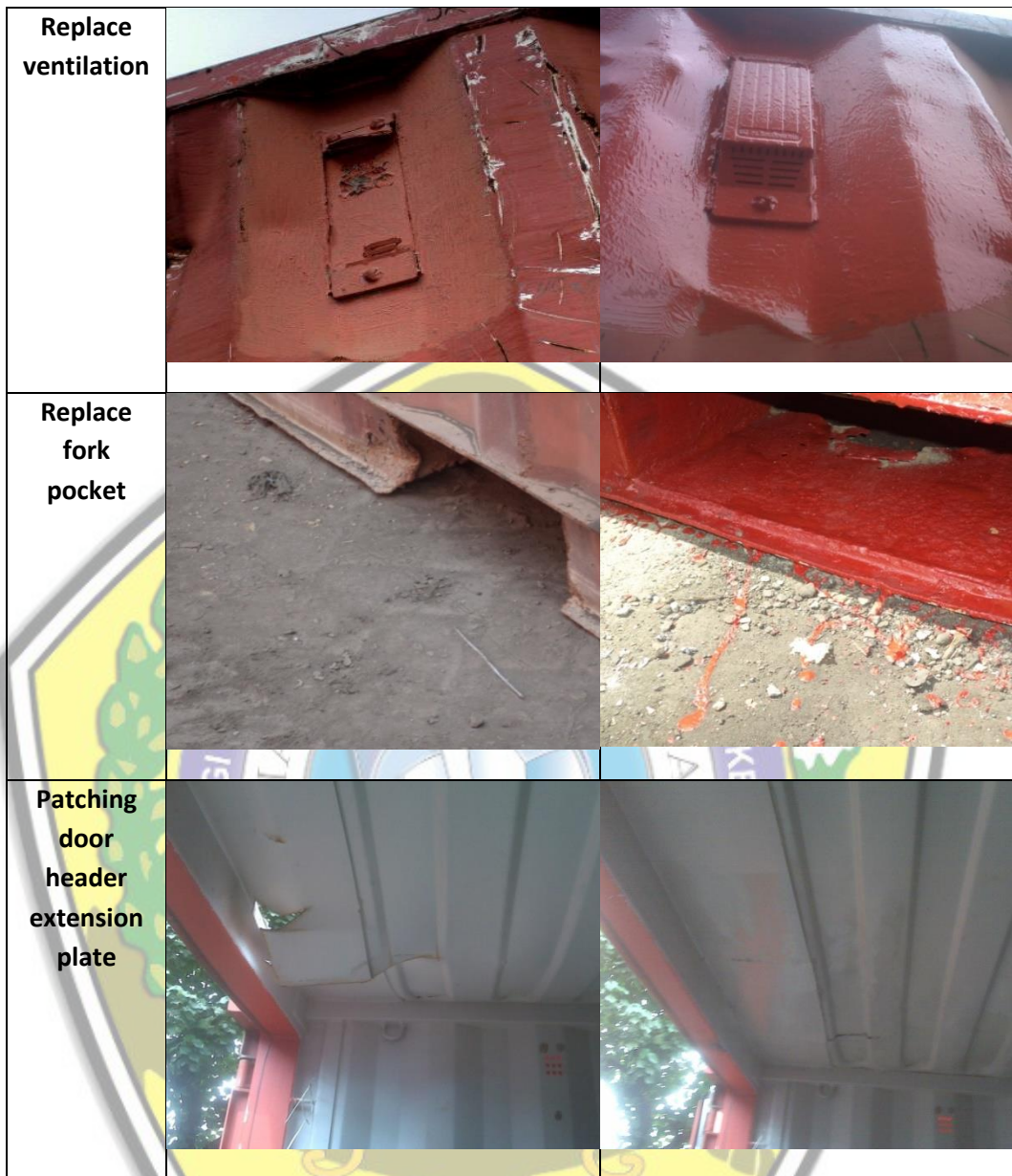
Gambar 1. Foto Sebelum dan Sesudah dilakukan Perbaikan
