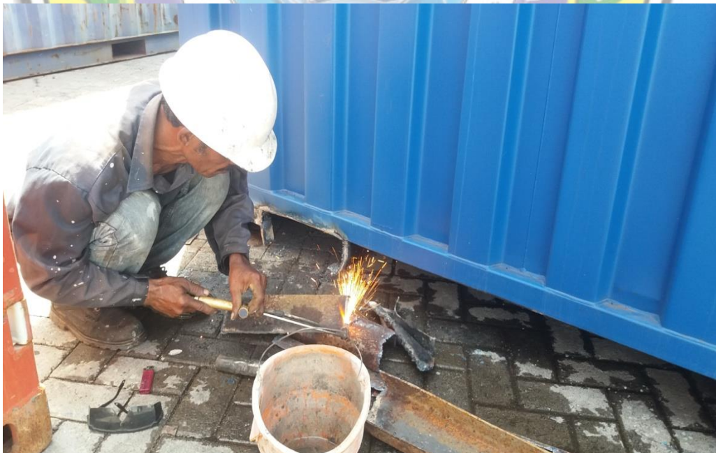
Gambar 5. Proses pengerjaan repair container .
