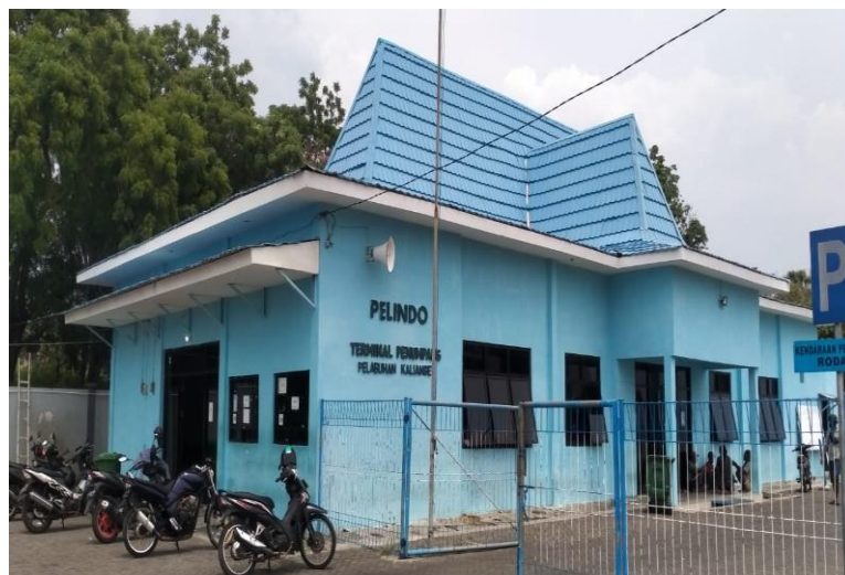
Gambar 2.2 Kantor Pelayanan Di Pelabuhan Kalianget Kab. Sumenep Sumber : Dokumentasi pribadi
