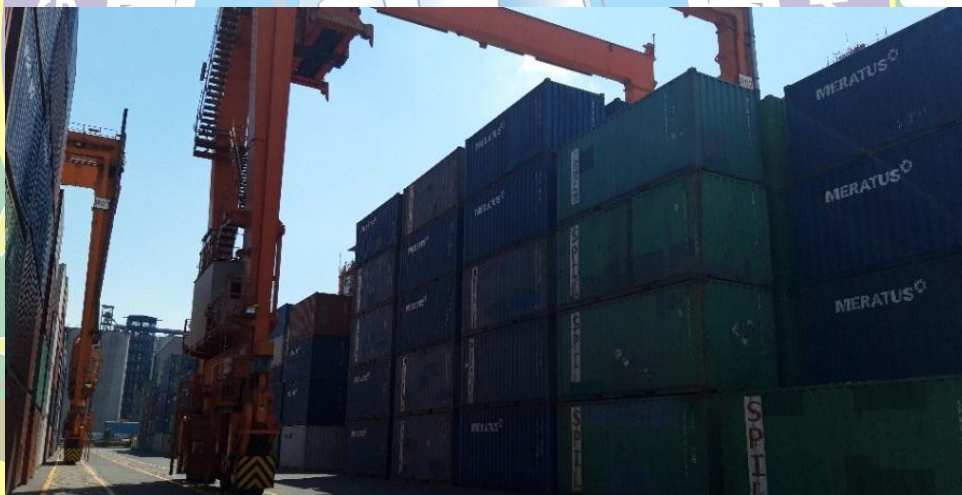
Gambar 2.2 Alat Rubber Tyred Gantry di lapangan penumpukan Sumber : PT. Nilam Port Terminal Indonesia
